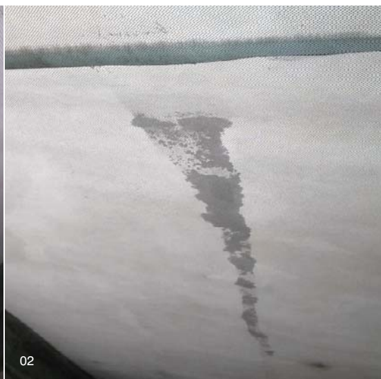
02 | Průsak po zkušebním nalití vody na fólii
