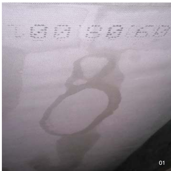
01 | Stopy po průsaku mikroporézní fólií
