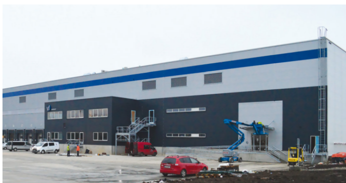
Park D8, Hala 6, etapa I. a II. , Zdíby – komplexní certifikace BREEAM pro distribuční halu o vnitřním objemu 550 000 m 3 .
