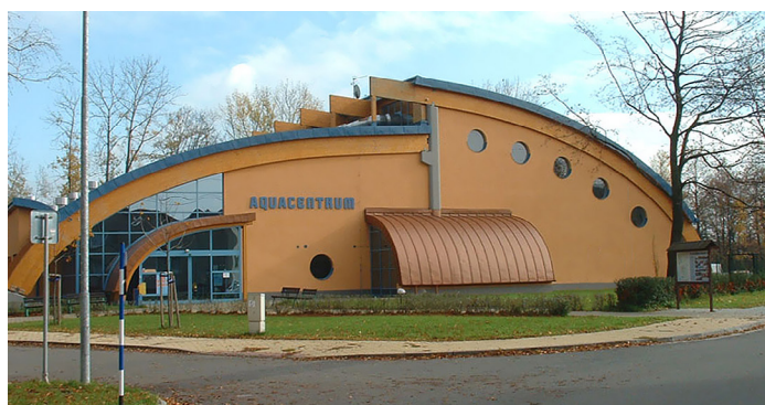
Aquacentrum Bohumín – znalecký posudek tepelně-vlhkostního chování střešního pláště. Projekt a autorský dozor opravy.
