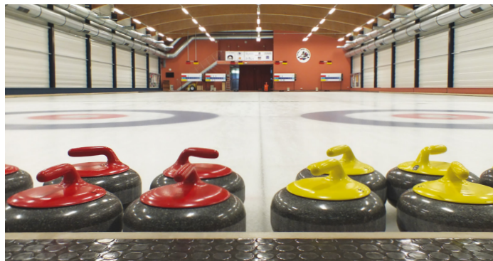
Curlingová hala , Praha – termodiagnostika a měření průvzdušnosti haly pro lokalizaci vadných částí střešního pláště.
