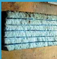
04 | vzorek ze střechy B rozdělený na vrstvy pro zjištění dílčích hmotnostních vlhkostí jednotlivých vrstev, z povrchu desky odstraněna vrstva plastbetonu
