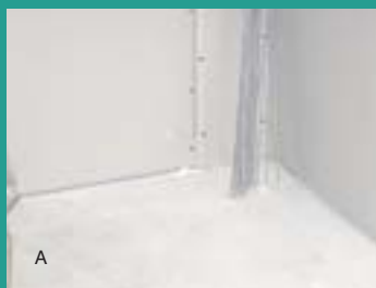
19| Styk podlahy a obvodové stěny v pracovně, kde se nacházela výrazná netěsnost.
