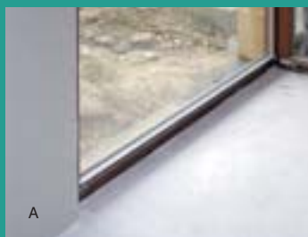
18| Dolní část francouzského okna v obývacím pokoji, patrné jsou výrazné netěsnosti v přípojovací spáře okna, které odpovídají přípojovacím kotvám.
