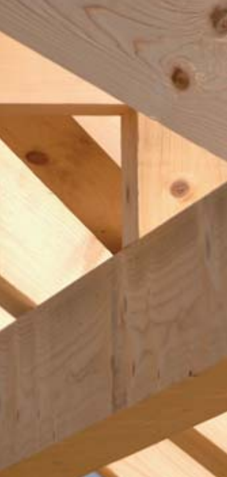
nosný dř. sloupek 60×120 mm á 625 mm
