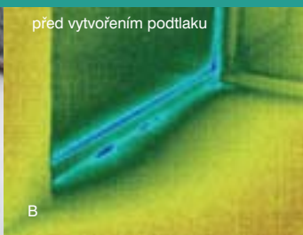
18| Dolní část francouzského okna v obývacím pokoji, patrné jsou výrazné netěsnosti v přípojovací spáře okna, které odpovídají přípojovacím kotvám.
