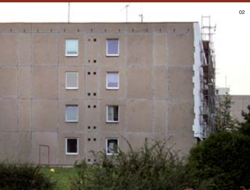
Obr. 03| Náhradní hnízdiště v ETICS pod parapety s možností kontroly
