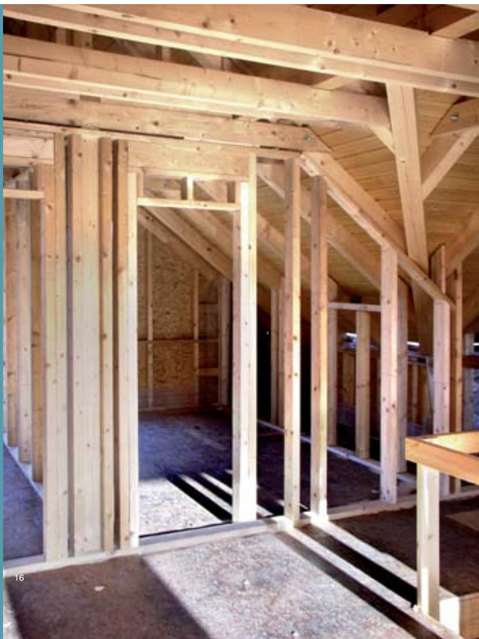
16 | Dokončený krov včetně bednění, rozpracované příčky v podkroví dřevostavby DEKHOME
