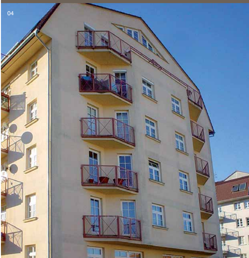
04 | Nestejnomyerné zašpinění ETICS termoprecipitací ovlivněné různými povrchovými teplotami
