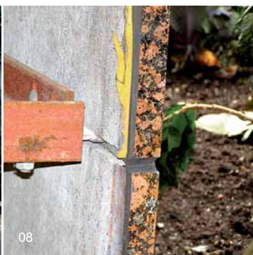
08 | Částečně demontovaný obklad u vstupu do objektu na fotografii /07/
