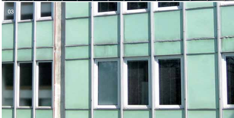
01, 02 | Fasáda z Boletických panelů
