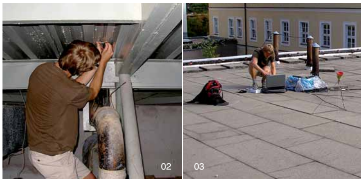
01 – 03 | Záběry z instalace čidel vnitřní povrchové teploty
