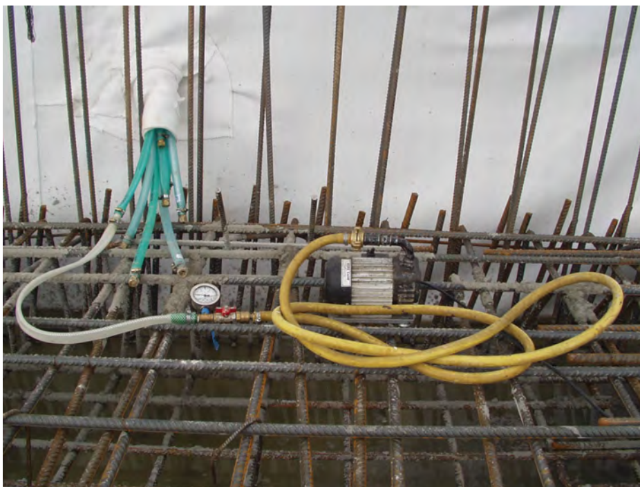
Foto 9. Kontrola těsnosti sektorové hydroizolace po provedení výztuže.
