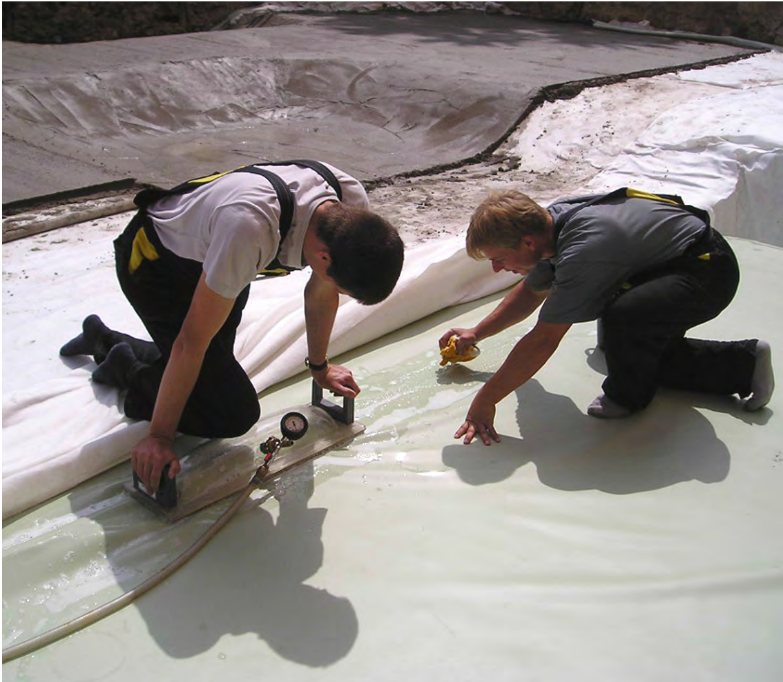
Foto 7. Zkoušení těsnosti spojů vakuovou zkouškou.
