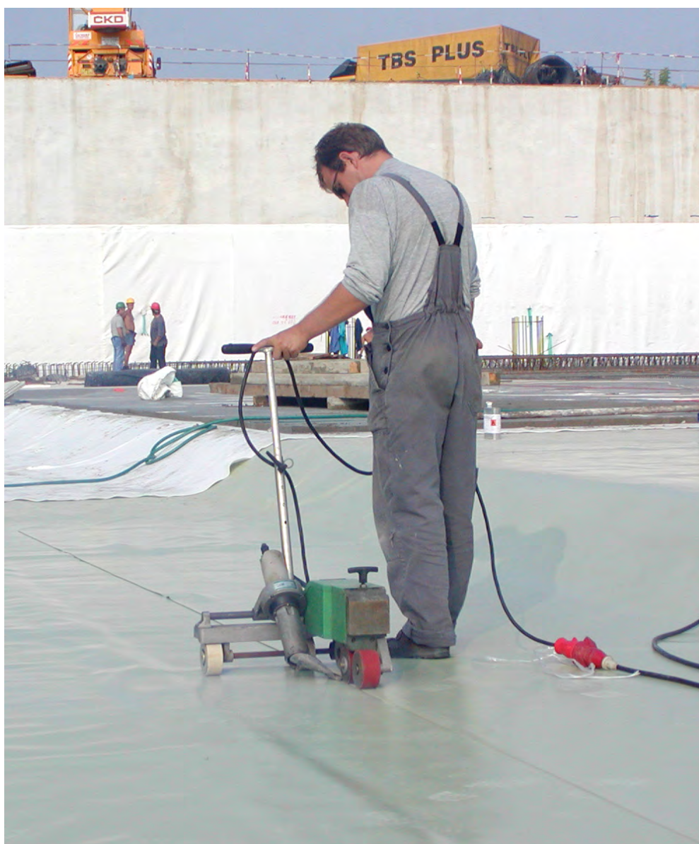
Foto 3. Práce se svařovacím automatem LEISTER VARIMAT.
