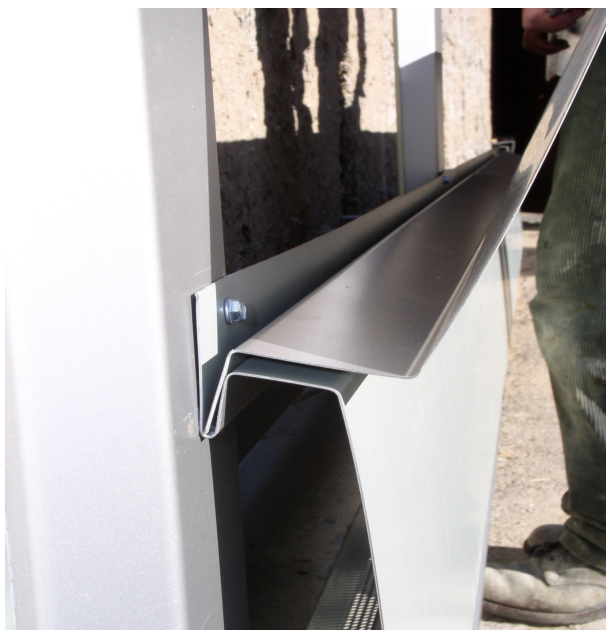
Obr. 18 Schéma zámku lamel.
