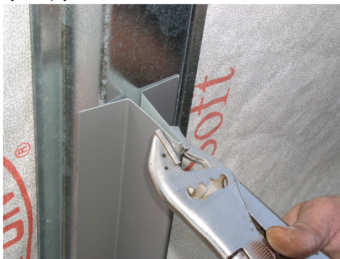
Obr. 47 Úprava vrcholu T lišty.
