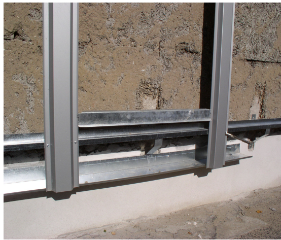
Obr. 13 a obr. 14 Montáž profilů OM
