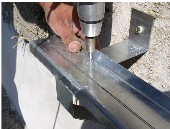
Obr. 8 Osazení profilu Z50 na A-konzolu.
