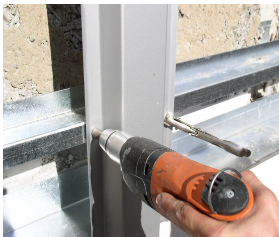
Obr. 13 a obr. 14 Montáž profilů OM
