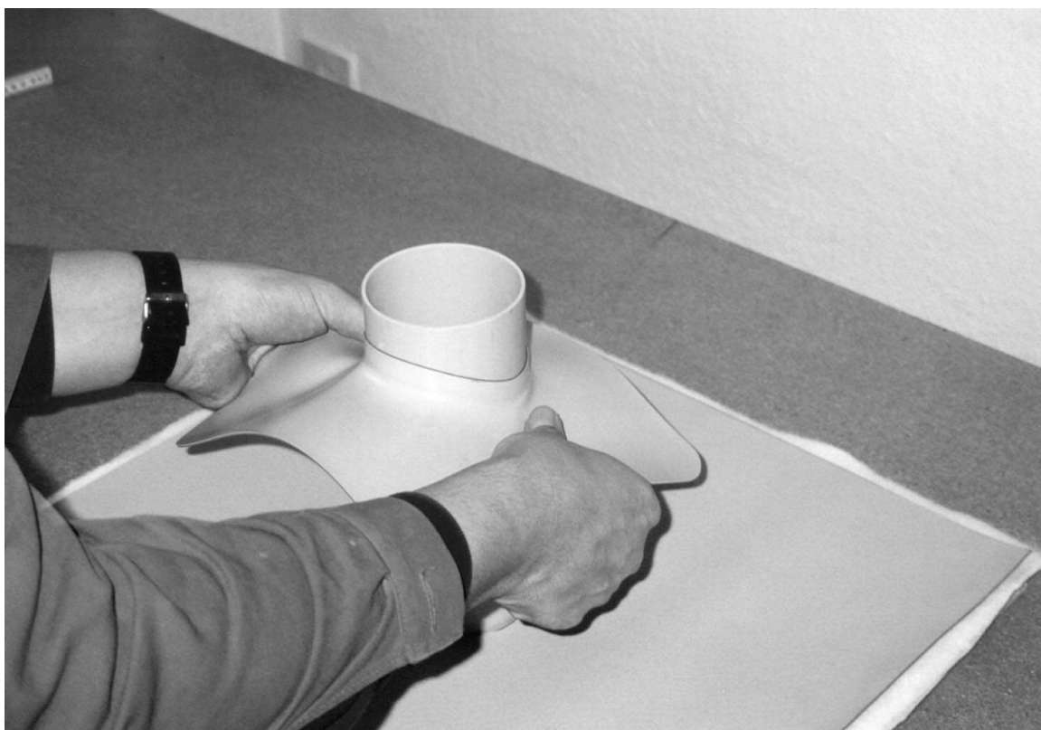
Obrázek 22.: Opracování prostupu - nasazení manžety na prostup
