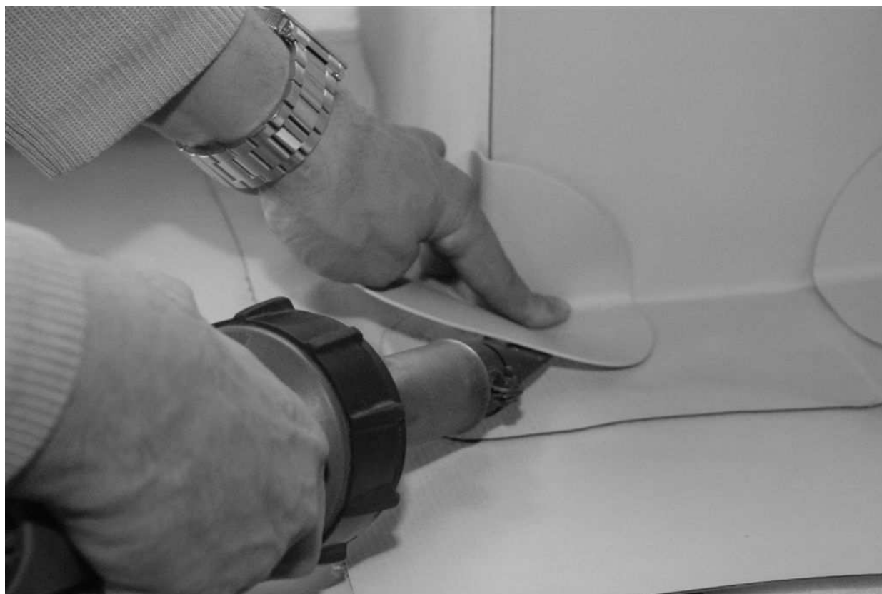
Obrázek 16.: Postup opravování hydroizolace na rohu
