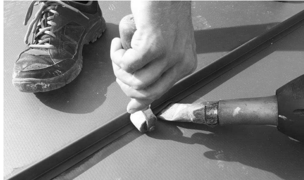
Obrázek 2.: Schéma s velikosti profilů ALKORDESIGN, ruční svařování profilů k fólii
