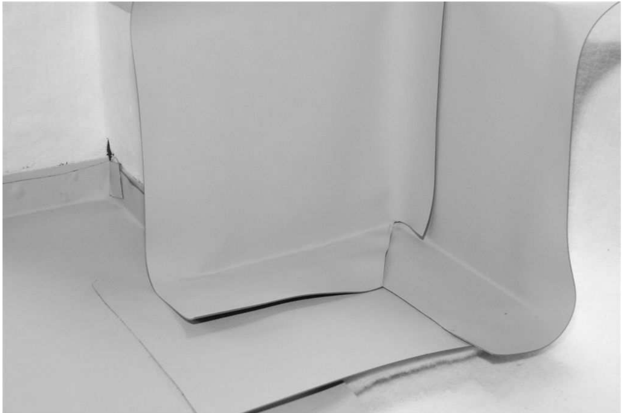
Obrázek 13.: Postup opracování hydroizolace v koutu
