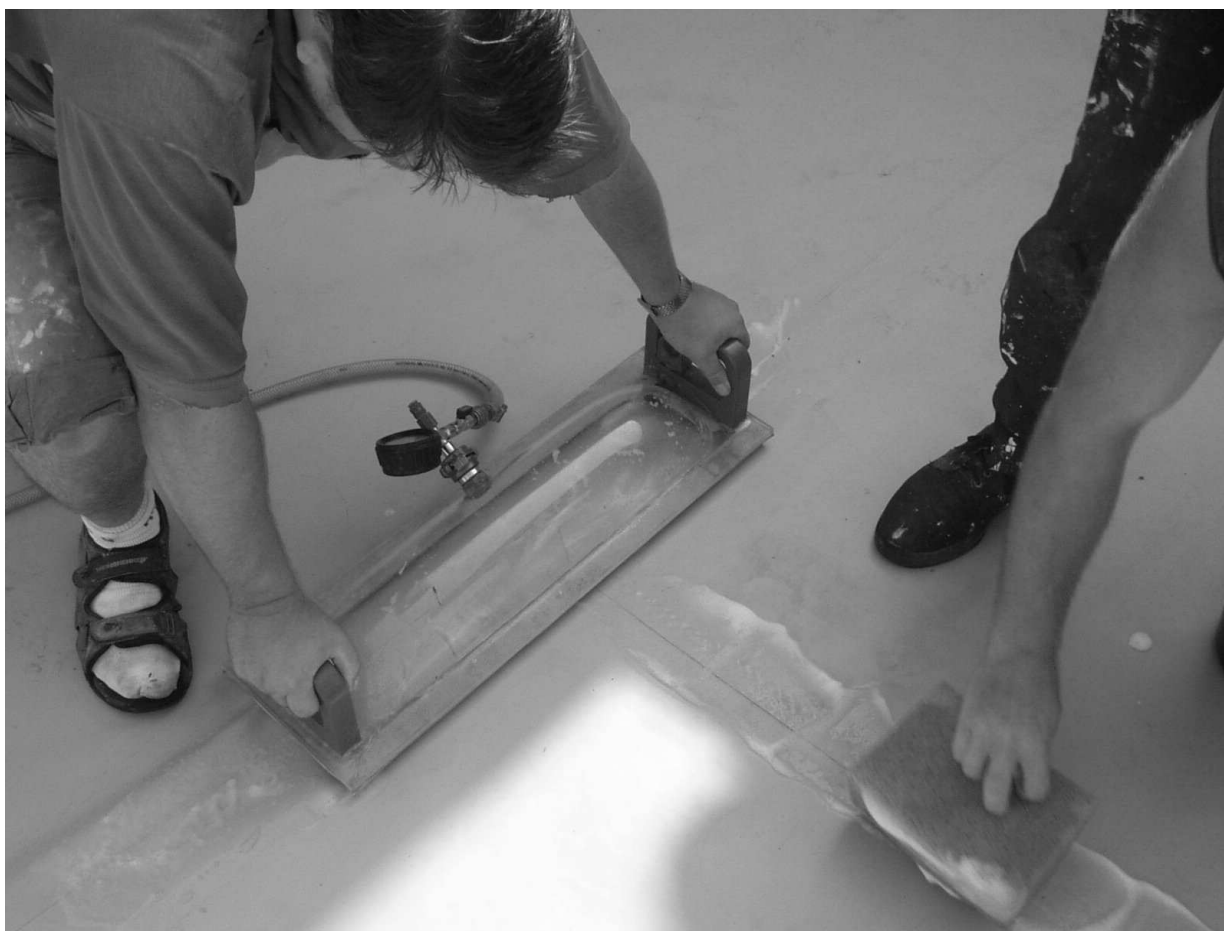
Obrázek 27.: Zkoušení těsnosti spojů vakuovou zkouškou
