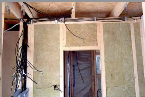
04 | Desky s čedičových vláken jako tlumící výplň příčky
