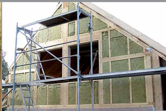
06| Desky z čedičových vláken jako tepelněizolační výplň vnější stěny
