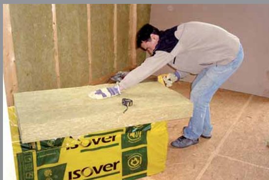
03 | Řezání desky z čedičových vláken
