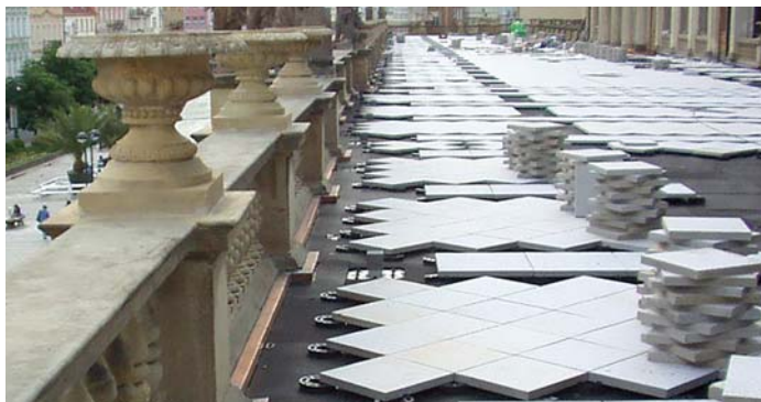
Mlýnská kolonáda , Karlovy Vary – projektová dokumentace a autorský dozor rekonstrukce izolačního souvrství terasy s vysokou spolehlivostí (dvojitý hydroizolační systém).
