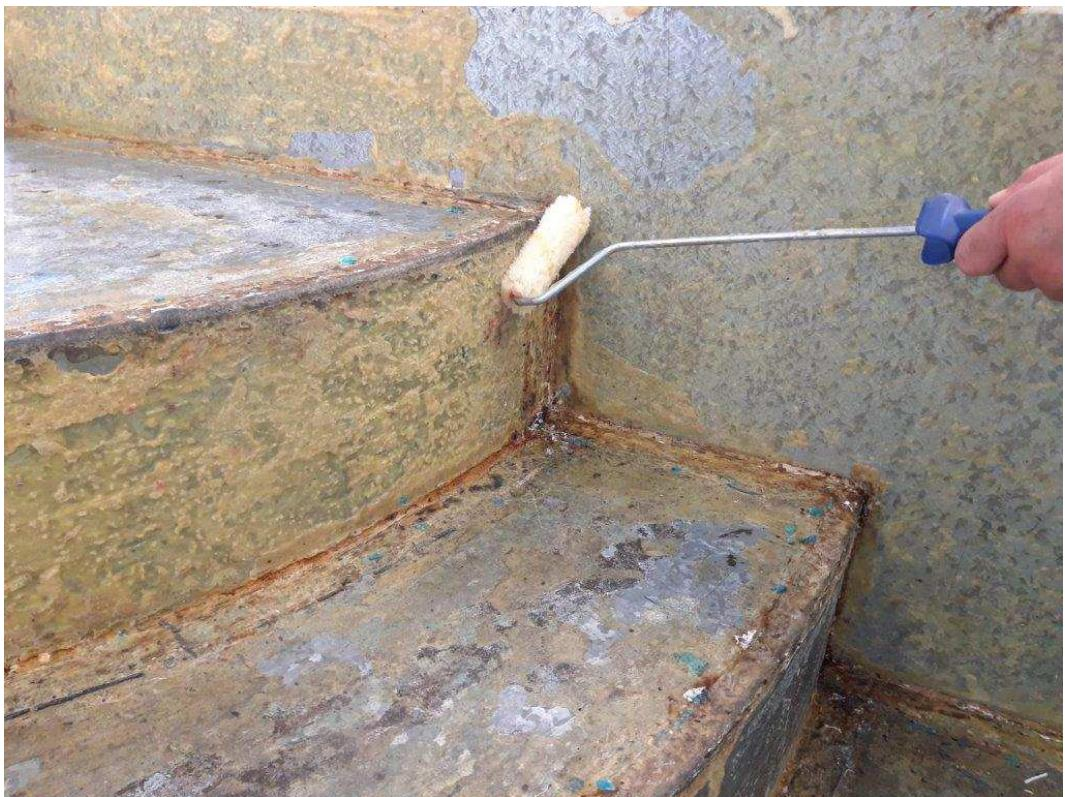
**Foto 7. Nanášení lepidla na podklad**
