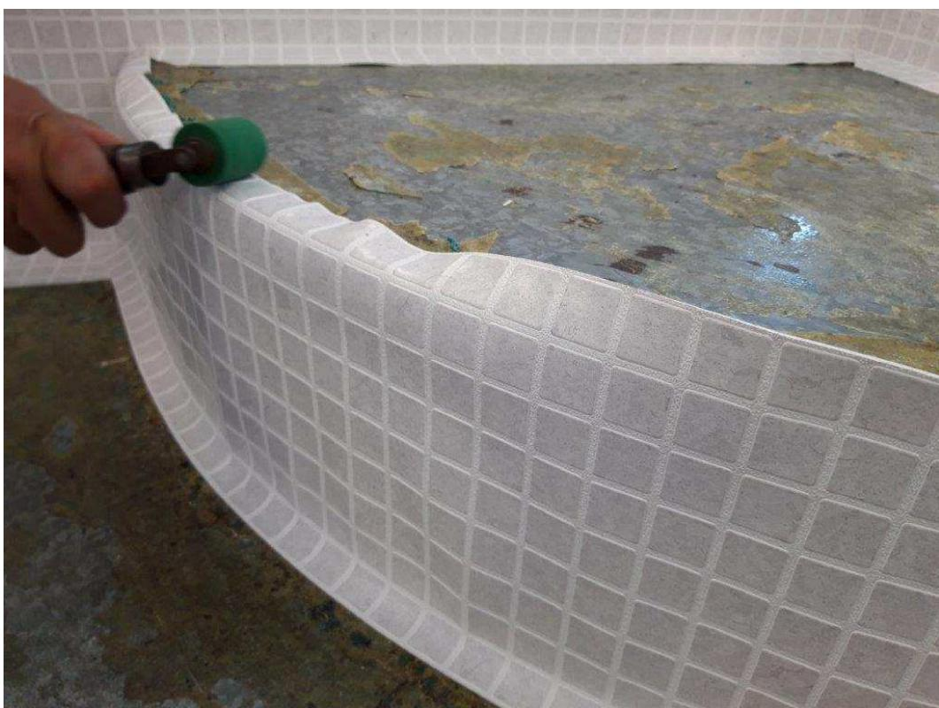
**Foto 14. Přilepení fólie s přítlakem válečku**
