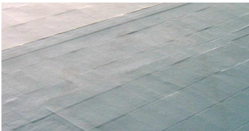
**Foto 4. Prokreslení staré dlažby na povrch fólie.**
