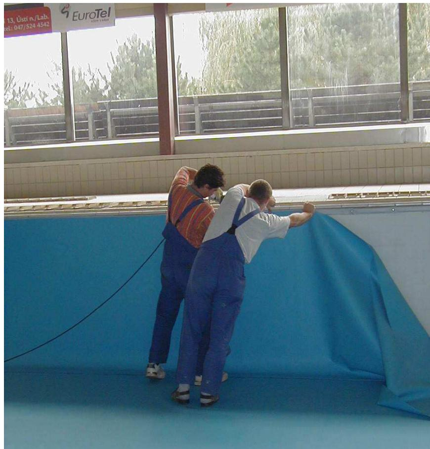
**Foto 5. Provádění stěny bazénu.**
