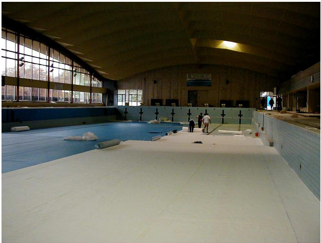
Foto 21. Bazén Ústí nad Labem – provádění dna bazénu
