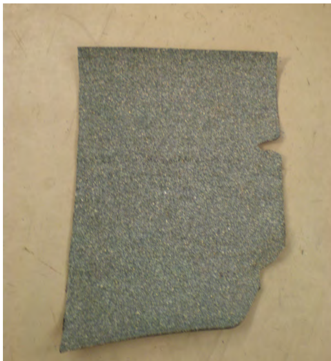
Obrázek /24/ Speciální tvar asfaltového pásu s posypem přivedeného po atice k detailu vnitřního koutu
