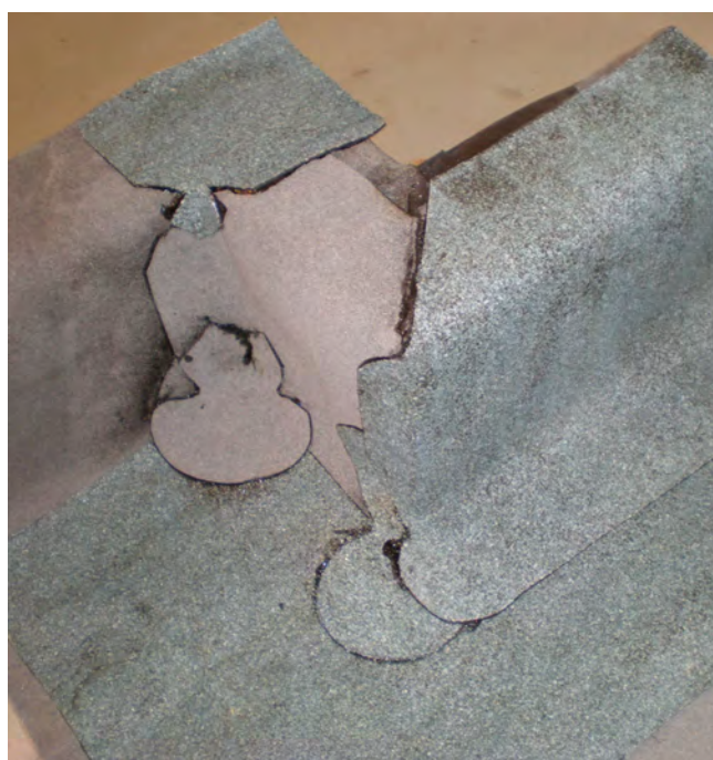
Obrázek /23/ Natavení upraveného asfaltového pásu s posypem přivedeného po atice k detailu vnějšího rohu
