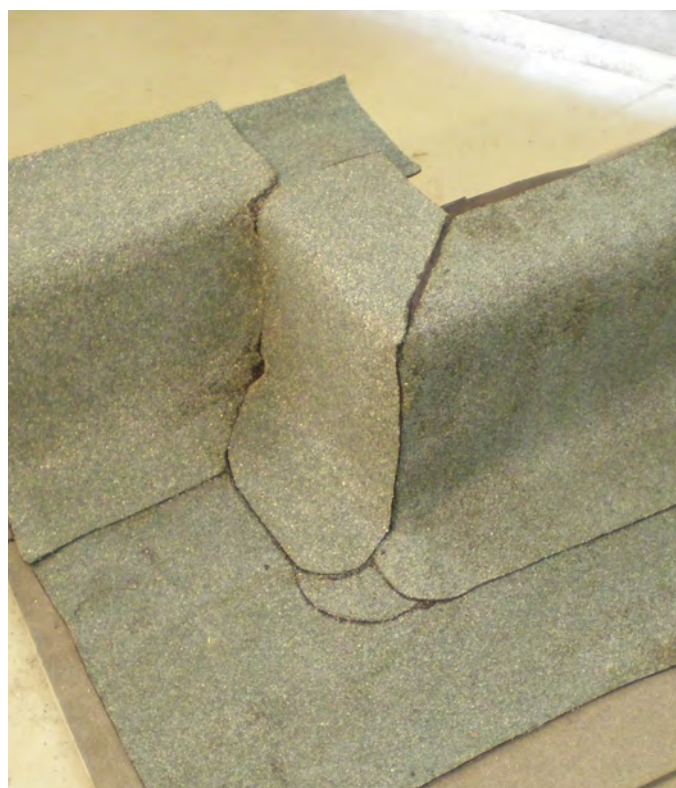
Obrázek /27/ Dokončení detailu vnitřního koutu a vnějšího rohu
