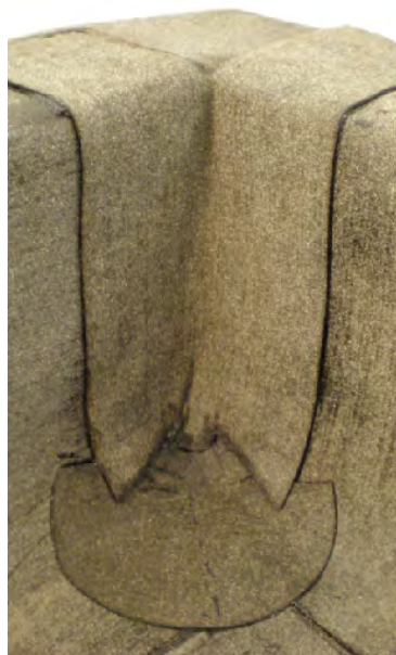
Obrázek /11/ Natavení univerzální tvarovky 3 a 2 bez posypu a koutové tvarovky 2
