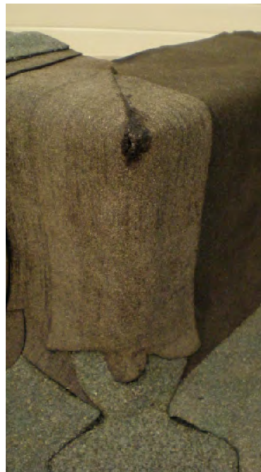
Obrázek /12/ Natavení univerzální tvarovky 3 s posypem a univerzální tvarovky 4 bez posypu (při nedokonalém tvaru podkladu vnějšího rohu doporučujeme použít univerzální tvarovku 4 s posypem pro ulehčení napojení rohových tvarovek 2a a 2b)
