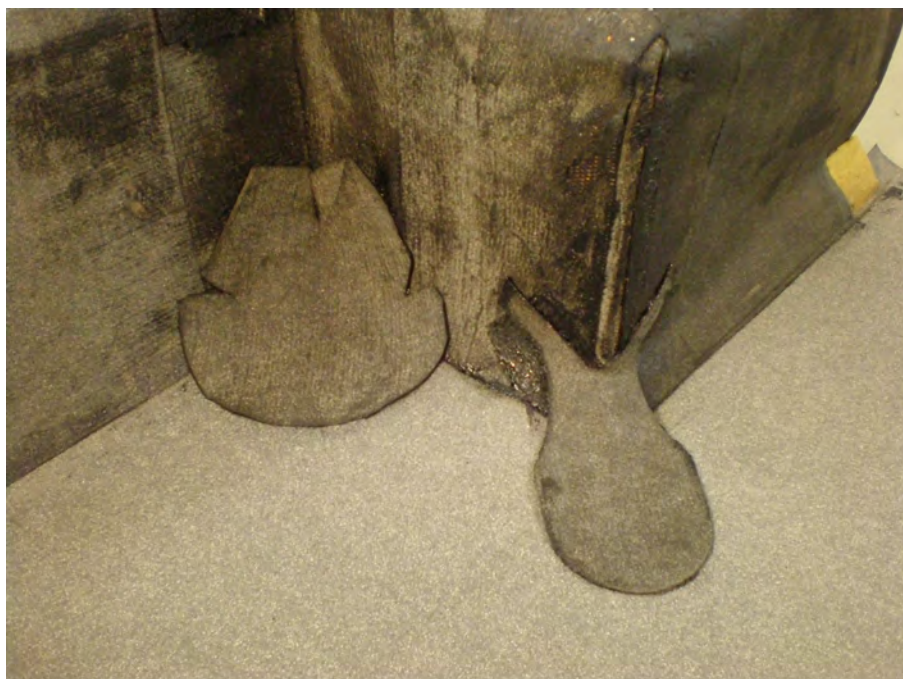
Obrázek /15/ Natavení univerzálních tvarovek 1 a 3 (bez posypu), asfaltový pás z plochy je přiveden k detailu
