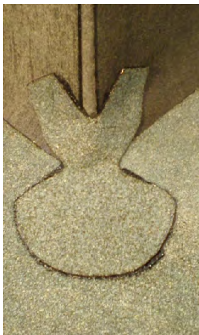
Obrázek /12/ Natavení univerzální tvarovky 3 s posypem a univerzální tvarovky 4 bez posypu (při nedokonalém tvaru podkladu vnějšího rohu doporučujeme použít univerzální tvarovku 4 s posypem pro ulehčení napojení rohových tvarovek 2a a 2b)
