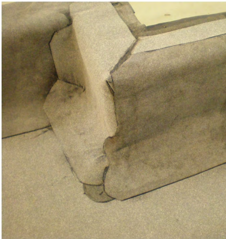
Obrázek /20/ Natavení upraveného asfaltového pásu přivedeného po atice k detailu vnějšího rohu
