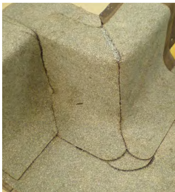
Obrázek /14/ Detail vnějšího rohu a natavení rohové tvarovky 2a (při použití univerzální tvarovky 4 s posypem nemusí rohová tvarovka 2a a 2b na sebe navazovat)
