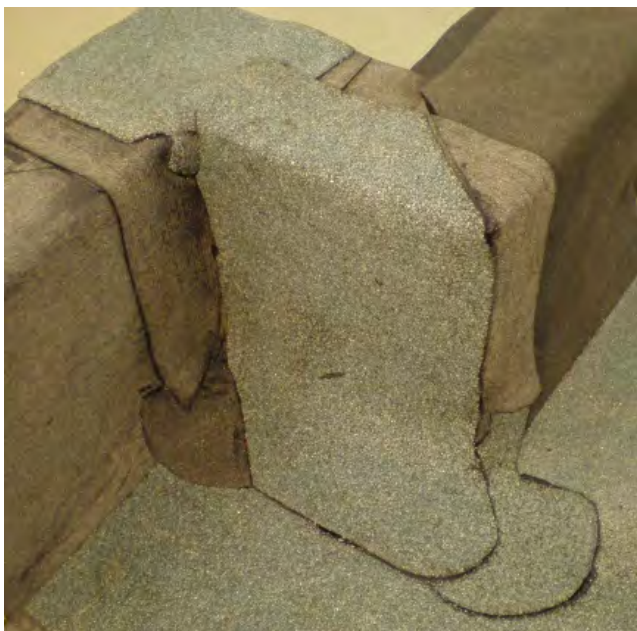
Obrázek /13/ Natavení koutové tvarovky 4b upravené zprava na tvar rohové tvarovky 2b a natavení koutové tvarovky 4a, obě s posypem
