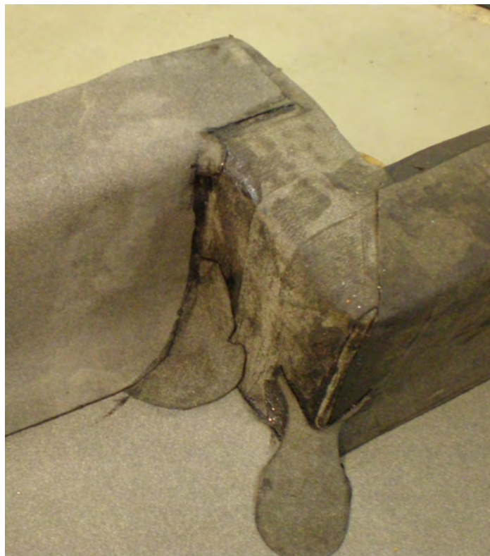
Obrázek /17/ Natavení upraveného asfaltového pásu přivedeného po atice k detailu vnitřního koutu
