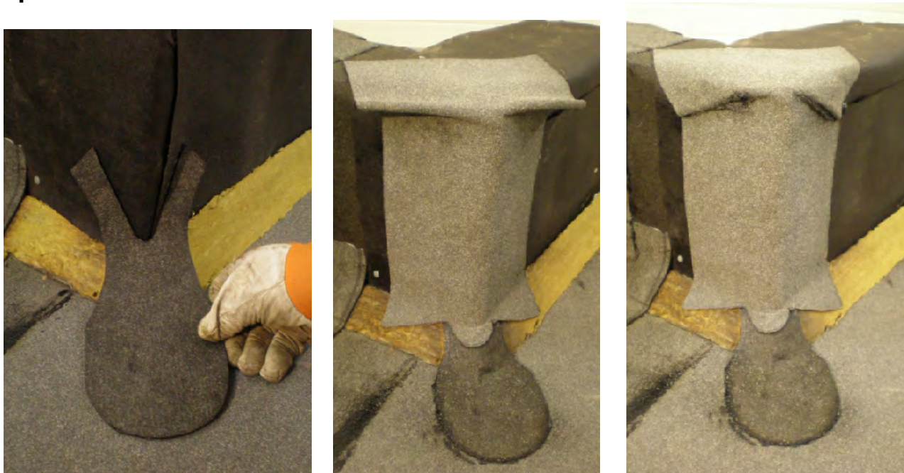
Obrázek /9/ Natavení univerzální tvarovky 1 a 2
