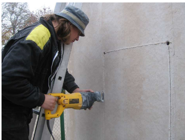
Foto 11: Vyřezávání otvoru pro okno v desce DEKCELL přímočarou pilou
