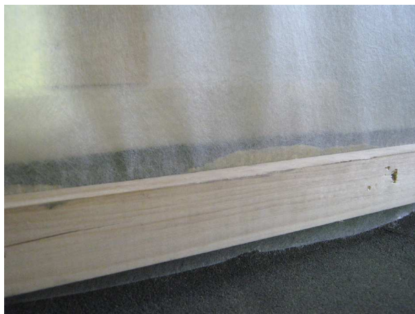
Foto 12, 13: Přiložení folie na nanesený proužek tmelu (vlevo) a pohled na dokončený spoj (vpravo)
