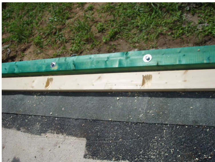
Foto 04: Otvory v dolním rámovém hranolku pro přečnávající závitové tyče
