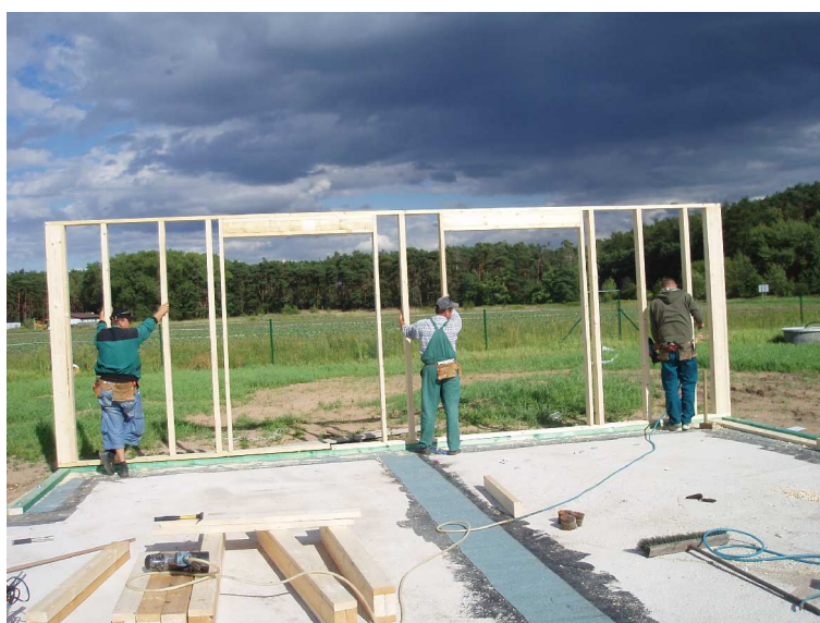
Foto 07: Vztyčení rámu stěny
