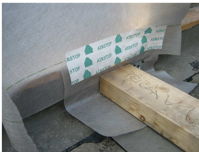
Foto 08: Spojení přířezů parotěsnicí folie AIRSTOP lepicí páskou AIRSTOP
