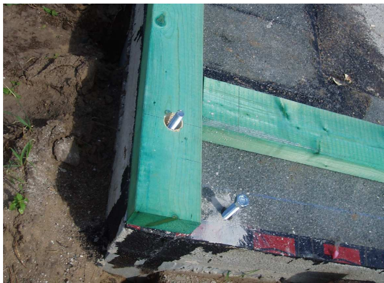
Foto 01: Závitová tyč připevňovaná do podkladu kotevní maltou a impregnované základové prahy s předvrtaným otvorem
