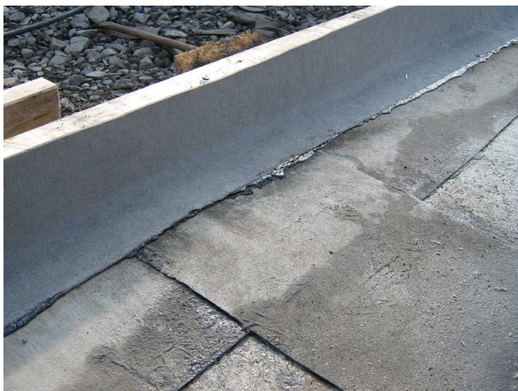
Foto 02: Pohled na natavený přířez asfaltového pásu
