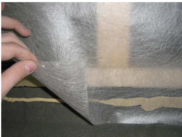
Foto 12, 13: Přiložení folie na nanesený proužek tmelu (vlevo) a pohled na dokončený spoj (vpravo)
