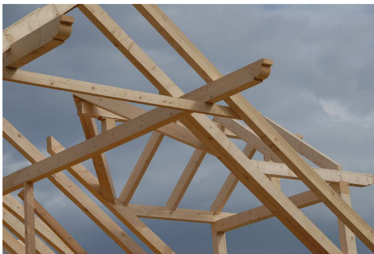
Foto 10: Montáž krovu z prvků s předem vyřezanými spoji
