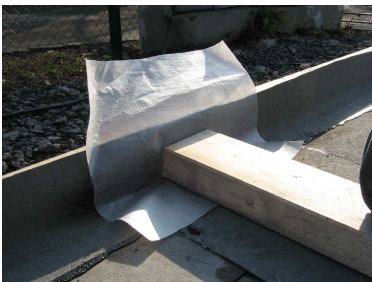
Foto 03: Přířez folie AIRSTOP pro pozdější napojení folie v ploše stěny
