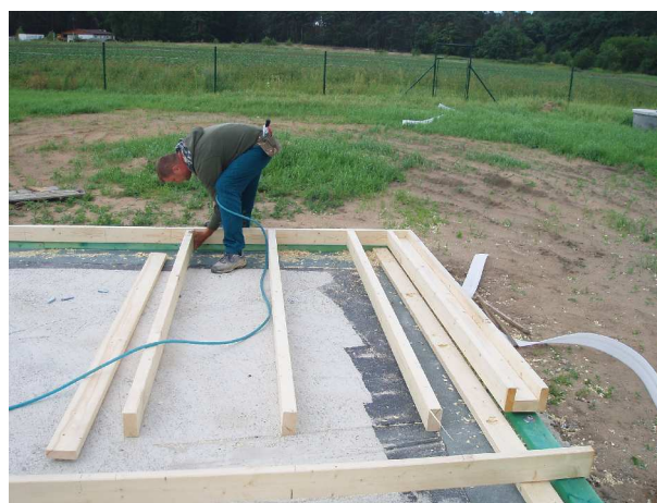
Foto 05, 06: Sestavování prvků rámu (vpravo) a jejich montážní spojení hřebíky (vpravo)
