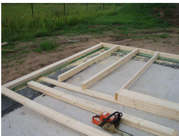
Foto 05, 06: Sestavování prvků rámu (vpravo) a jejich montážní spojení hřebíky (vpravo)
