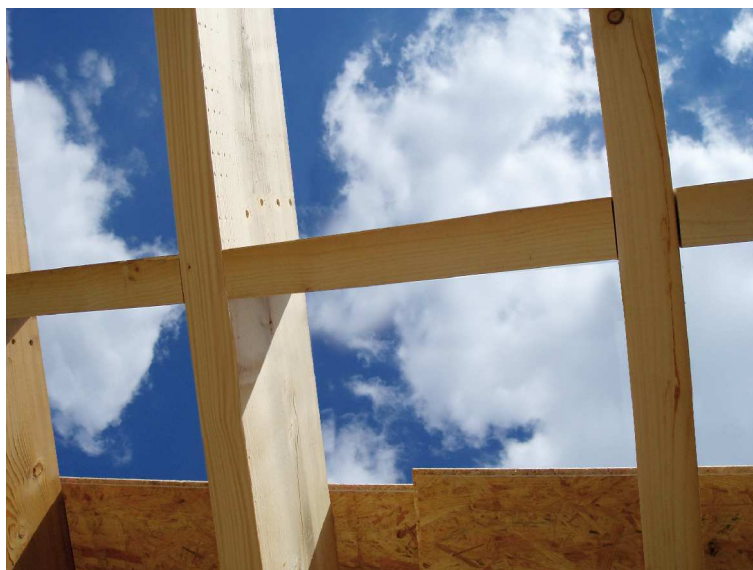
Foto 09: Rozpěry vložené mezi stropní nosníky (desky OSB jsou na nosníky pouze položeny)
