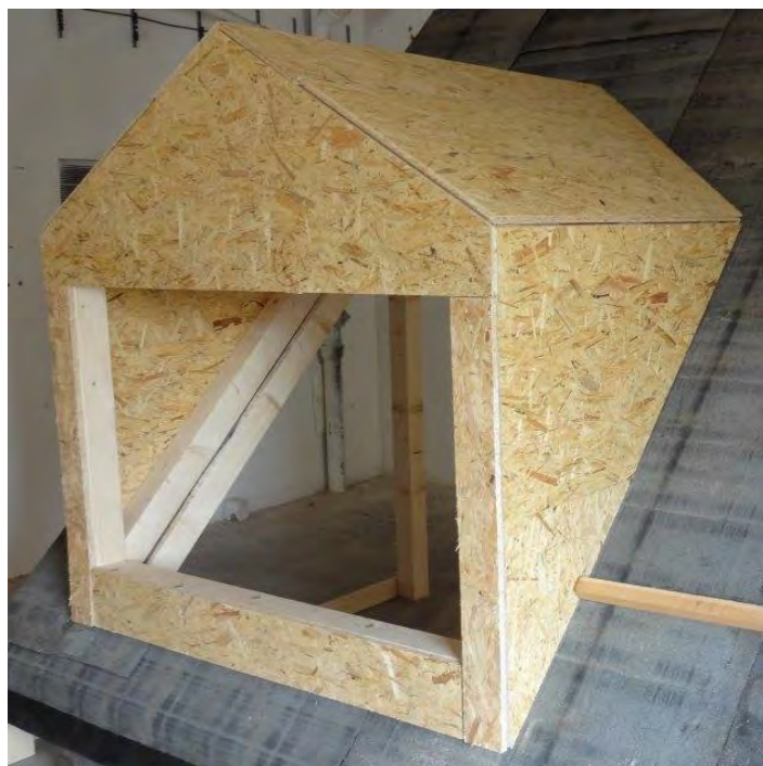
Obr. 29. Dokončené opláštění konstrukce vikýře
