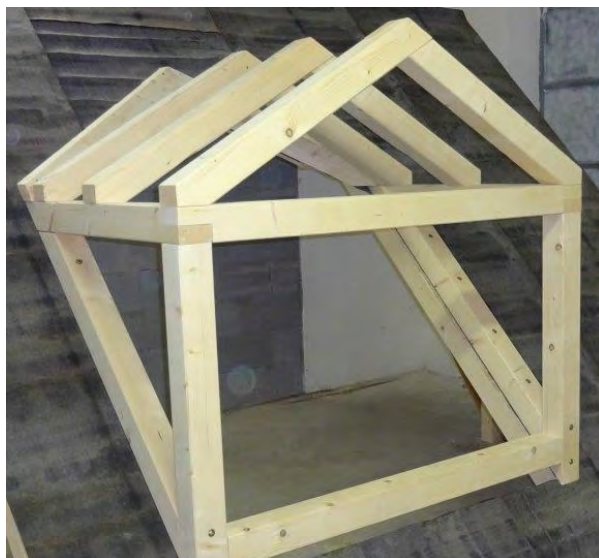
Obr. 27. Sestavená konstrukce vikýře
