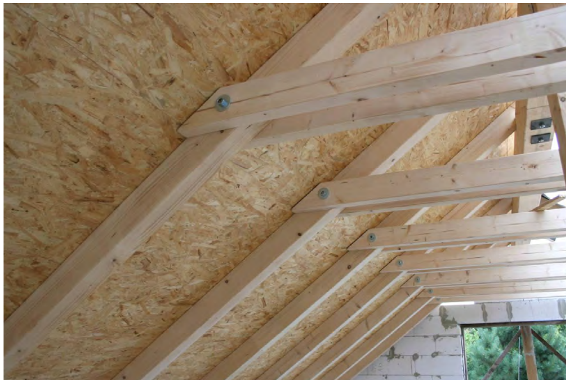
Obr 3. - Montáž bednění z desek OSB
