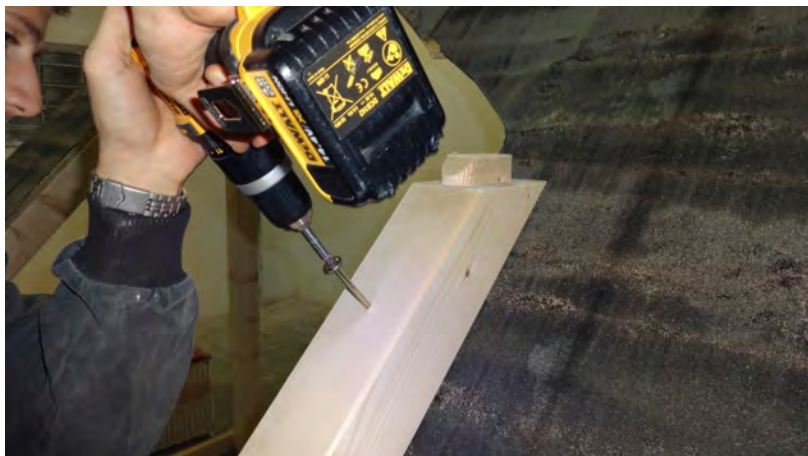
Obr. 26. Upevnění základních bočních dílů ke krokvi
