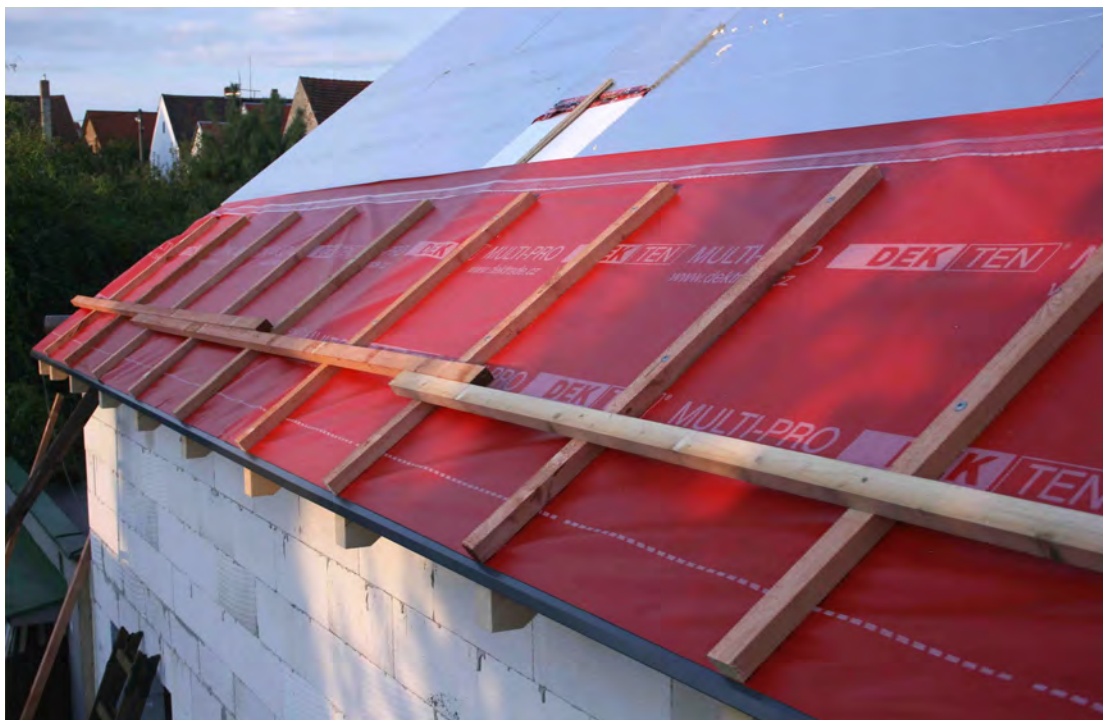
Obr 12. - Pokládka doplňkové hydroizolační vrstvy
