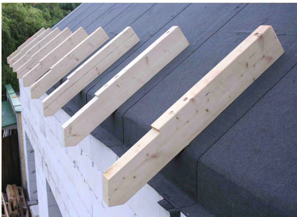
Obr 7. - Upevnění podpor přesahu střechy u okapu
