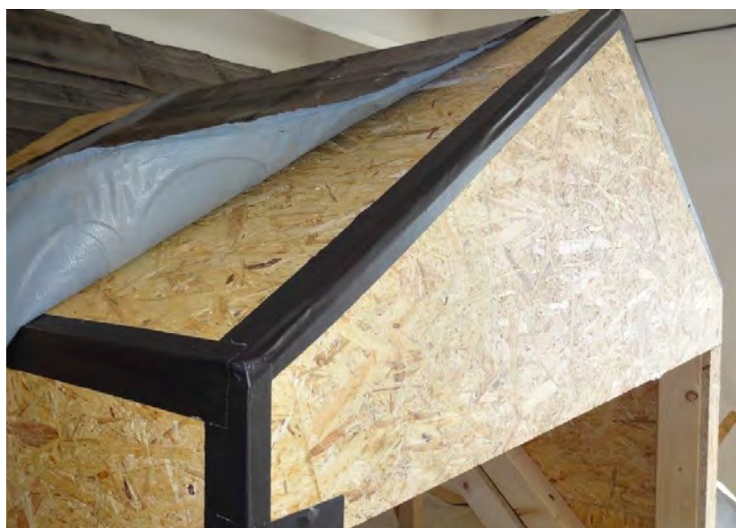
Obr. 30. Přelepení spár opláštění konstrukce vikýře
