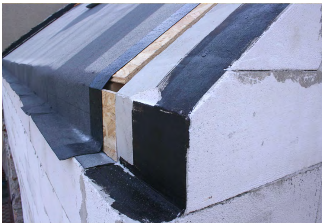
Obr 5. - Ukončení parotěsnicí a vzduchotěsnicí vrstvy z asfaltového pásu na obvodovém zdivu; štítová stěna má vyrovnaný a napenetrovaný povrch pro dobré přilnutí samolepicího pásu TOPDEK AL BARRIER.
