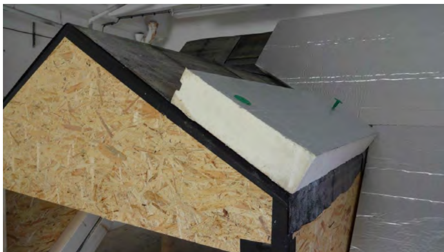
Obr. 31. Pracovní upevnění tepelněizolační vrstvy u okapní hrany
