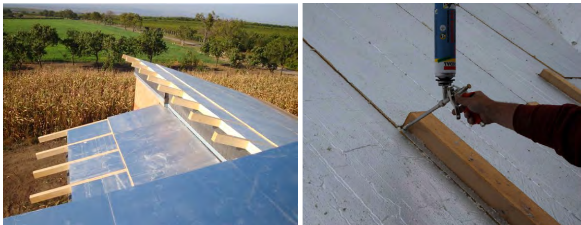
Obr 10. - Pokládka tepelněizolačních desek TOPDEK 022 PIR
