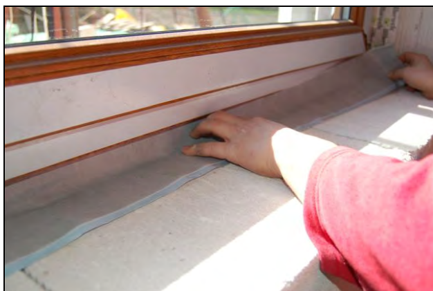
Foto 38 – Aplikace interiérové pásky v místě parapetu
