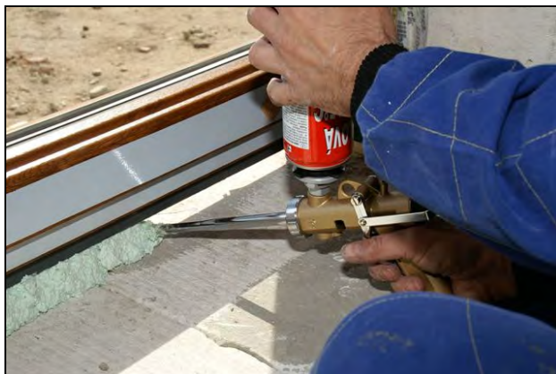
Foto 33, 34 – Vyplňování připojovací spáry PUR pěnou
