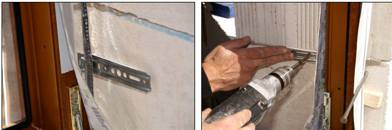
Foto 31, 32 – Upevnění rámu páskovou kotvou
