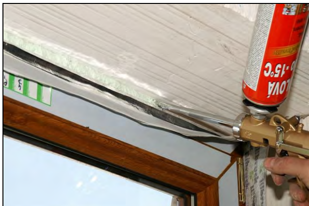
Foto 33, 34 – Vyplňování připojovací spáry PUR pěnou
