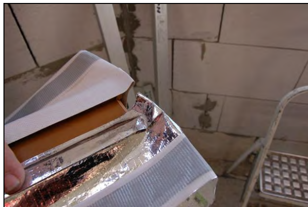
Foto 23, 24 – Nalepení těsnících pásek na rám, nařasení pásky v rohu
