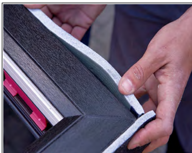
Foto 25, 26 – Nalepení pásky na rám a provedení v rohu okna
