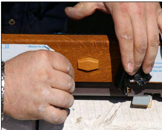
Foto 40, 41 – Osazení krytek a přišroubování klik
