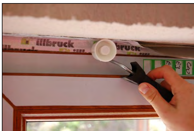
Foto 36, 37, 38 – Penetrace a válečkování interiérové pásky
