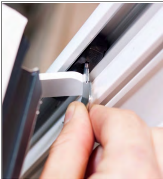
Foto 45, 46 – Odjištění horních pojezdů ve vodící liště
