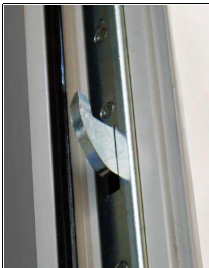
Foto 11 – Čep hákového zámku a hákový zámek s čepy
