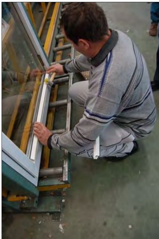
Foto 55 – Osazení vodorovné zasklívací lišty
