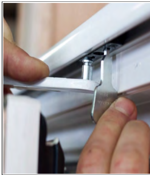
Foto 45, 46 – Odjištění horních pojezdů ve vodící liště
