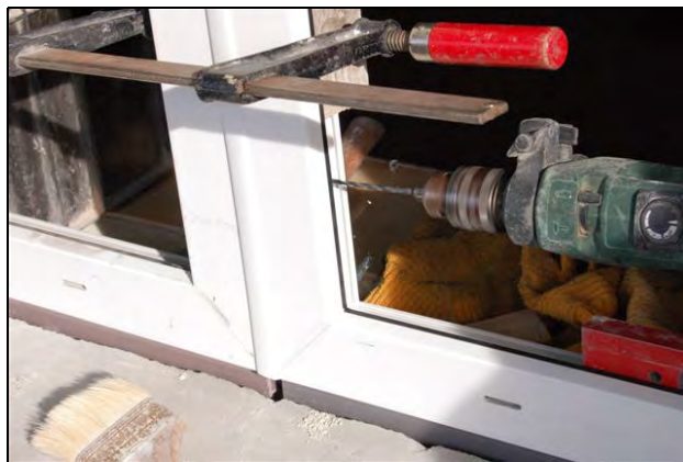
Foto 43 – Sepnutí a předvrtání ráků
