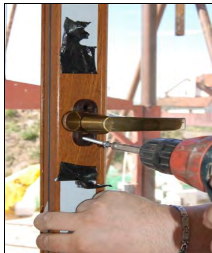
Foto 40, 41 – Osazení krytek a přišroubování klik
