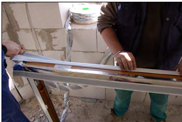
Foto 23, 24 – Nalepení těsnících pásek na rám, nařasení pásky v rohu
