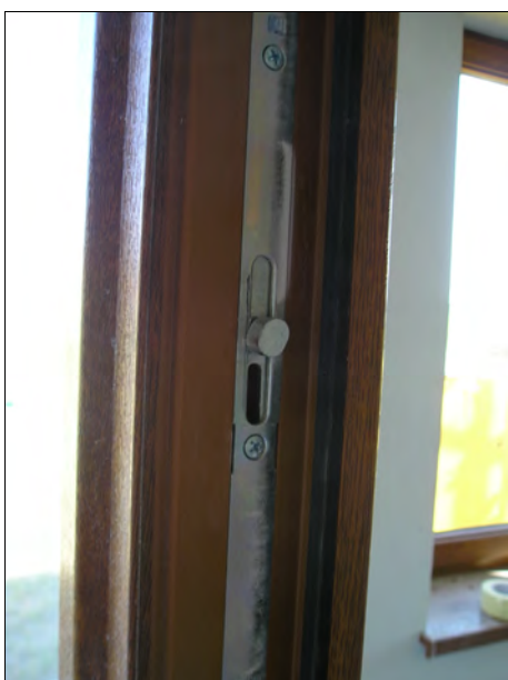
Foto 71 – Excentr na křídle
