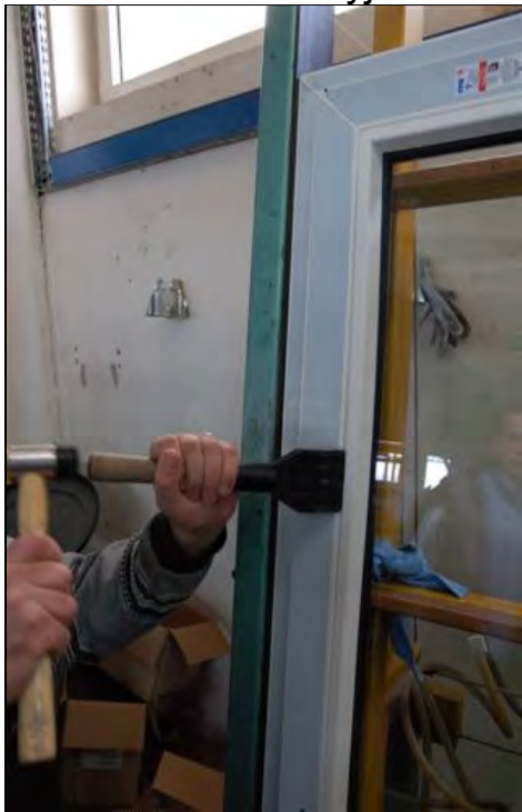
Foto 51 – Demontáž zasklívací lišty Foto 52 – Vyjmutí zasklení z rámu křídla
