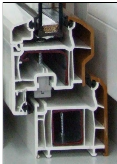
Foto 14 – Části profilu spojené koextruzí
