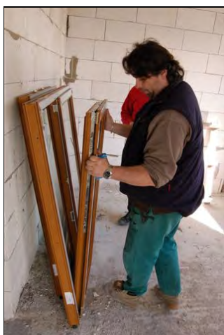
Foto 20, 21, 22 – Uvolnění závlačky z horního závěsu, vyjmutí křídla z rámu
