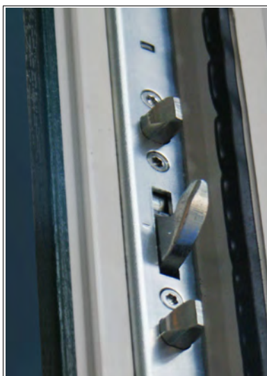
Foto 11 – Čep hákového zámku a hákový zámek s čepy
