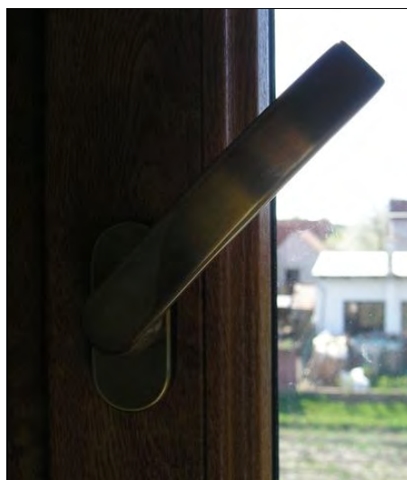
Foto 60 – 4. poloha kliky - mikroventilace
