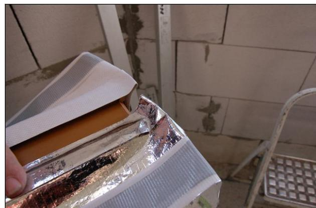
Foto 23, 24 – Nalepení těsnicích pásek na rám, nařasení pásky v rohu
