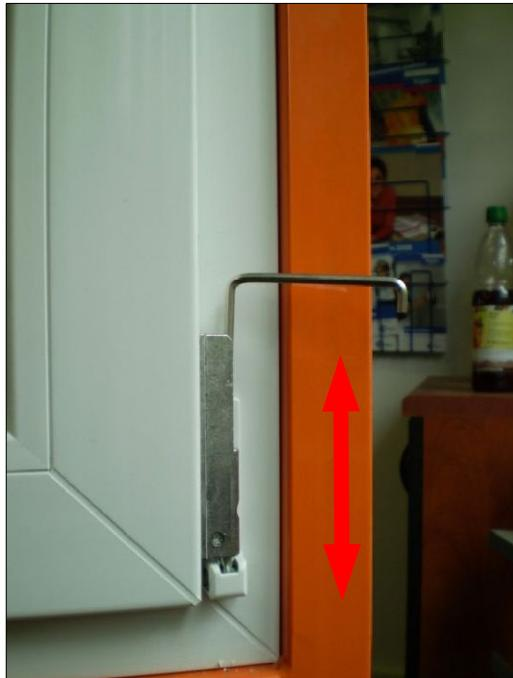
**Svislý posun křídla okna spodem.** Používá se v případě, když při zavírání křídla okna dochází k dotyku dílů kování na křídle a rámu okna.
