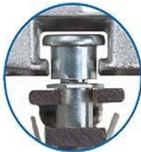
**Foto 10 –Bezpečnostní prvky kování (IS čep zasunutý v bezpečnostním protikusu)**
