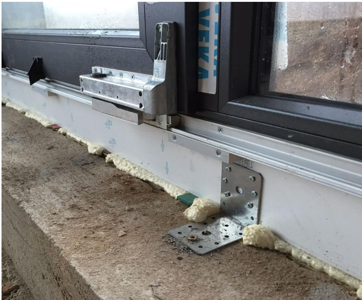
**Foto 51 – Způsob kotvení rozšiřovacího profilu HST systému do podkladu**
