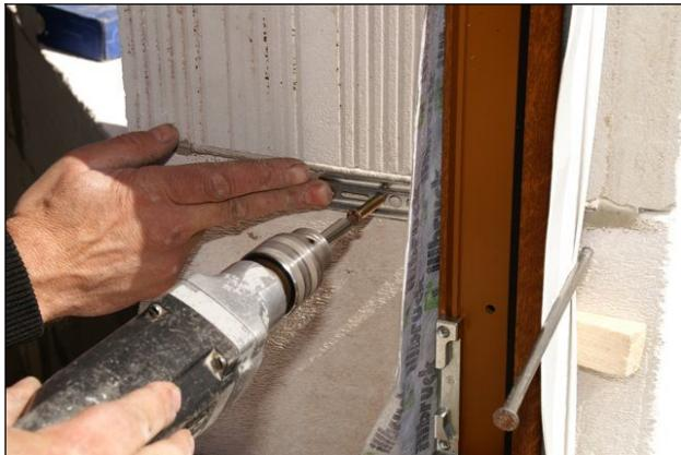
Foto 31, 32 – Upevnění rámu pásovou kotvou
