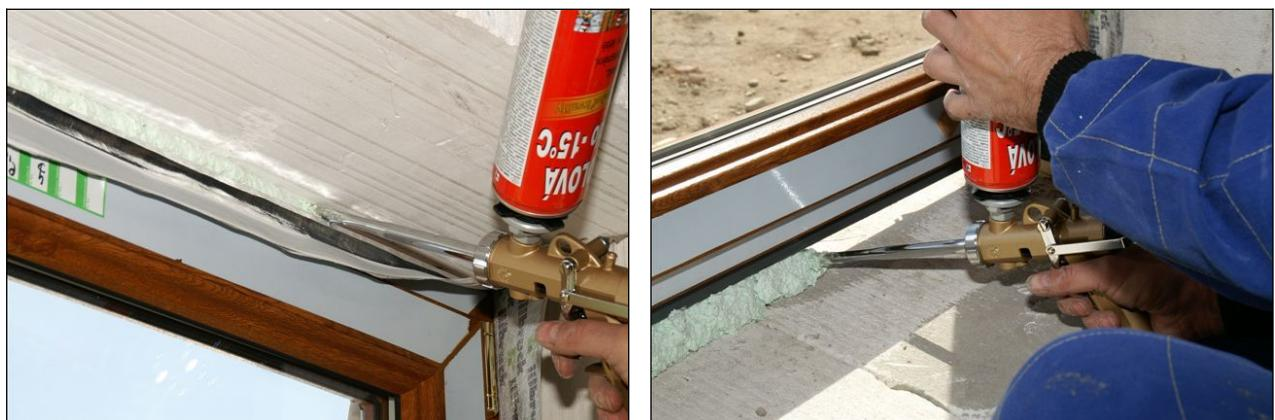
Foto 33, 34 – Vyplňování připojovací spáry PUR pěnou
