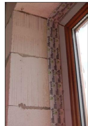
Foto 36, 37, 38 – Penetrace a válečkování interiérové pásky
