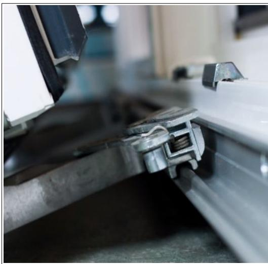
**Foto 47 – uvolněná kolejnica spodního pojezdu po naklonění křídla**
