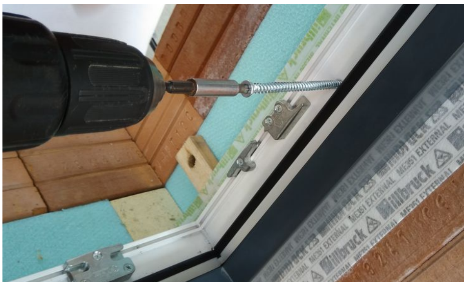
Obr. 38 – Kotvení okna pomocí turbošroubu
