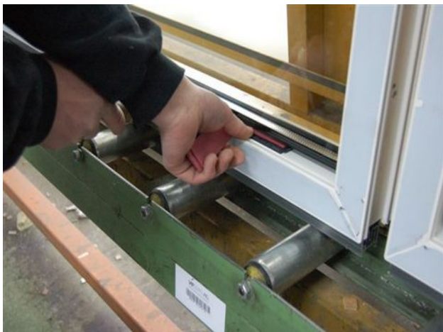
Obr. 96 – Vkládání podložek do rámu křídla
