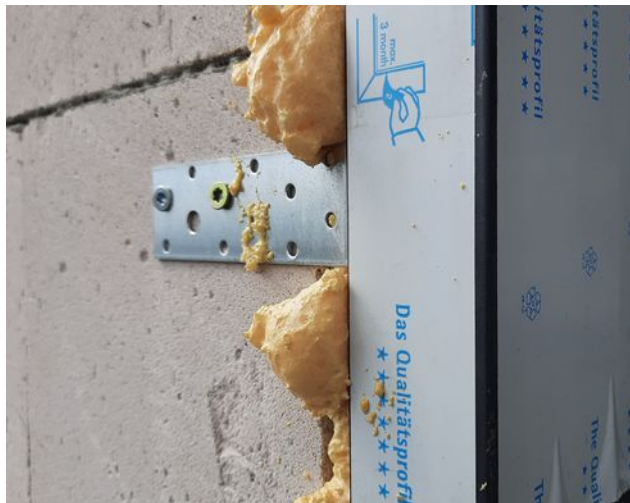
Obr. 66 – Kotvení HST portálu na exteriérové straně
