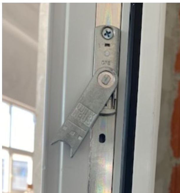
Obr. 90 – Pojistka proti chybné manipulaci kliky
