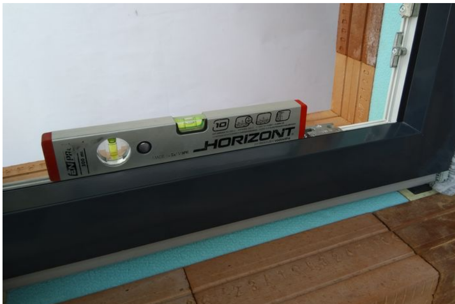
Obr. 30 – Kontrola vyrovnaní pomocí vodováhy
