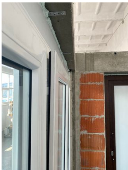
Obr. 85 – Maximální odsunutí mikroventilace křídla
