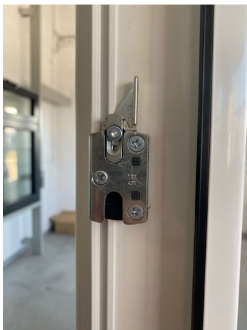
Obr. 89 – Protiplech balkónové pojistky v uzávěru
