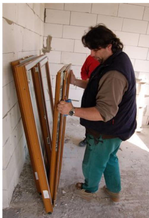
Obr. 22 – Vyjmutí křídla z rámu
