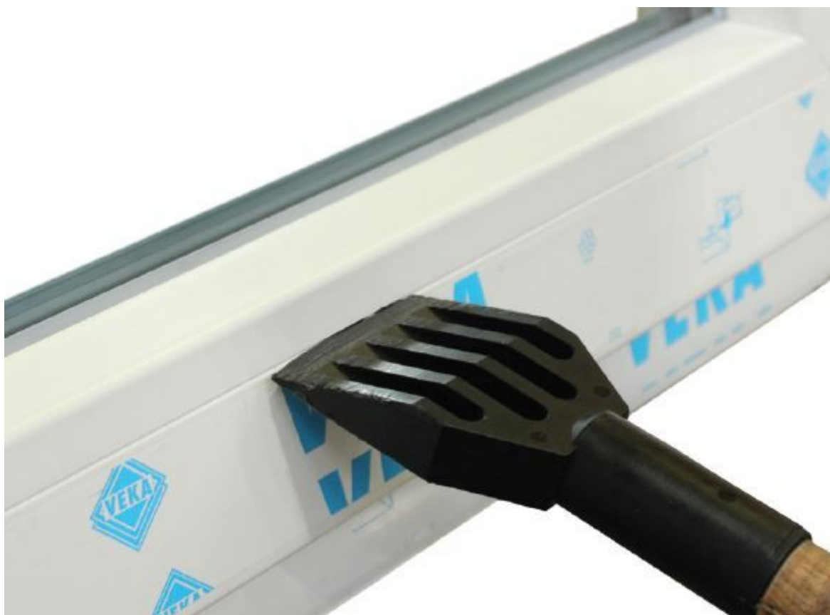
Obr. 91 – Demontáž zasklívací lišty pomocí zasklívací lopatky
