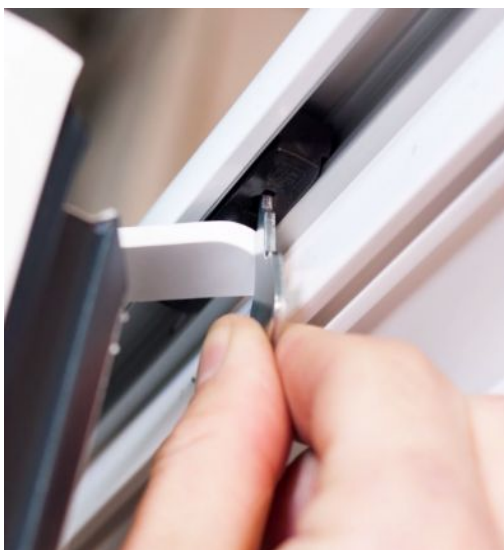
Obr. 56 – Odjištění horního pojezdu ve vodicí liště
