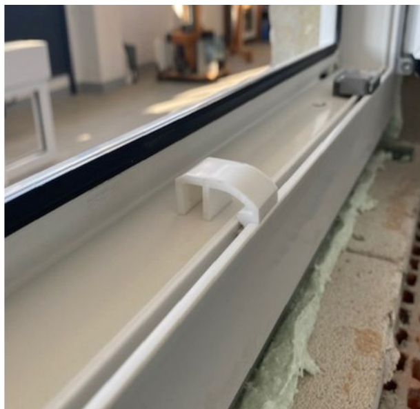
Obr. 18 – Plastový přepravní klínek osazený na okně
