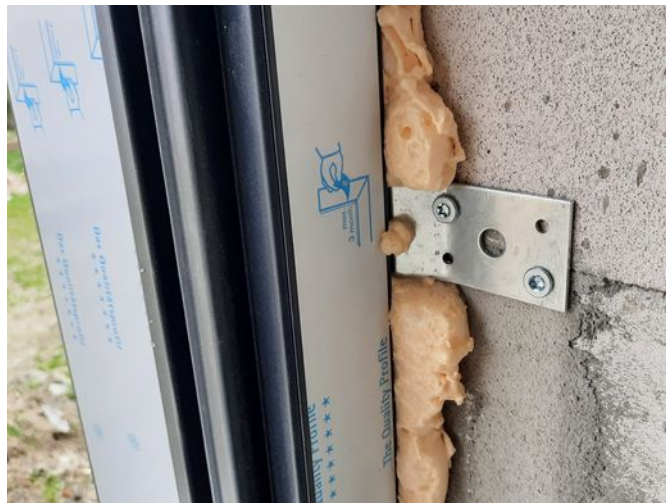
Obr. 67 – Kotvení HST portálu na interiérové straně
