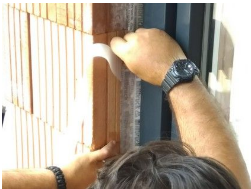
Obr. 45 – Nalepování exteriérové těsnicí fólie
