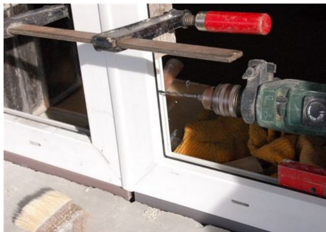
Obr. 51 – Předvrtání rámu
