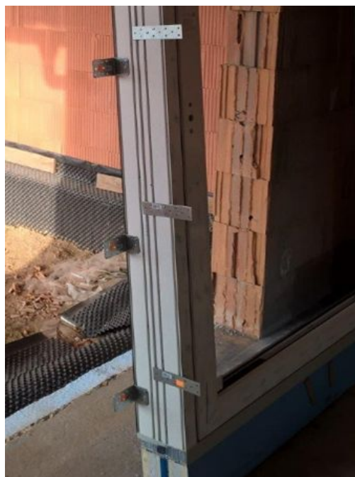
Obr. 65 – Montážní plechy na rámu
