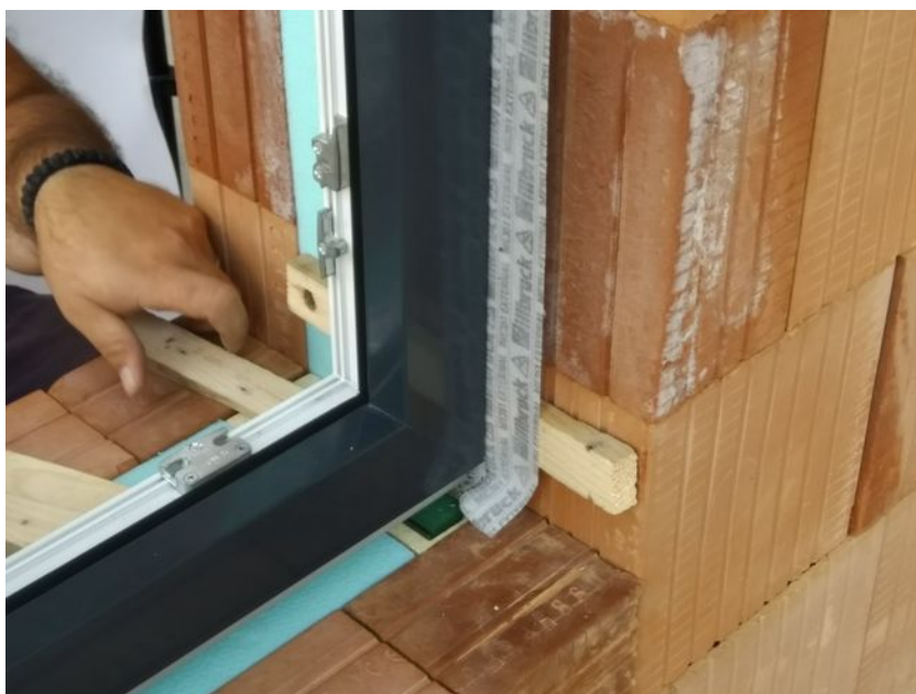
Obr. 29 – Pracovní zaaretování pomocí dřevěných klínů
