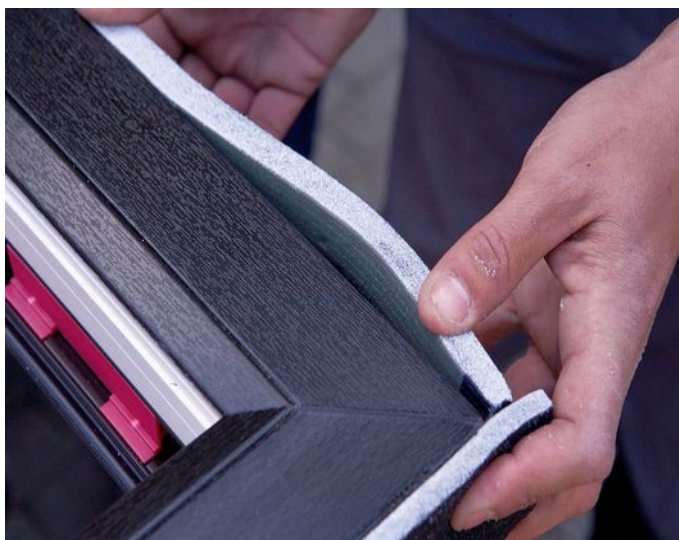
Obr. 27 – Provedení komprimační pásky na rohu výplně
