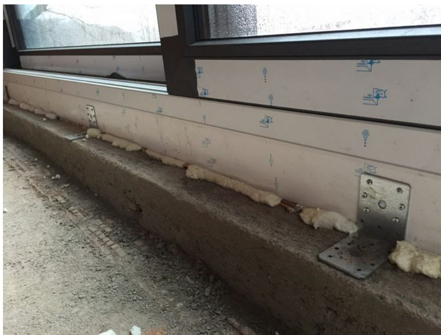
Obr. 60 – Provedení betonového prahu pod portálem v dostatečné šířce pro kotvení
