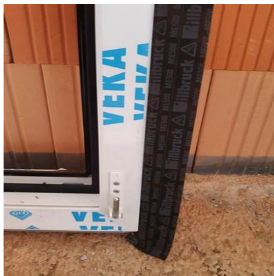
Obr. 25 – Nalepená těsnicí fólie na rámu
