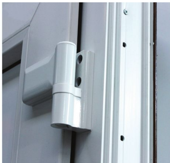
Obr. 54 – Předvrtané montážní otvory
