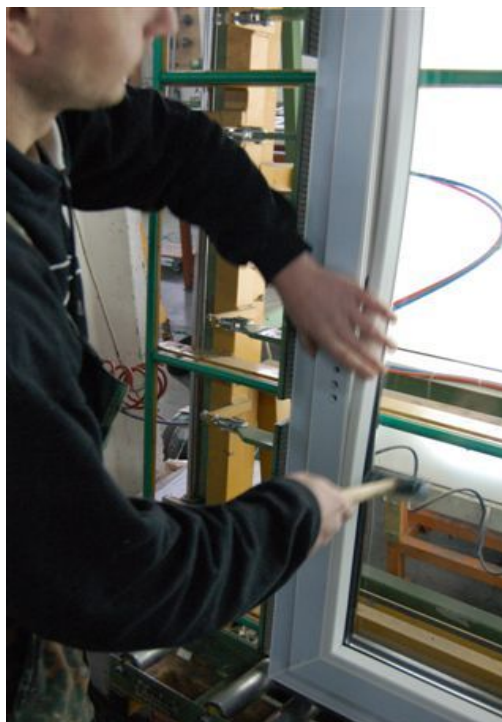
Obr. 99 – Osazení svislé zasklívací lišty
