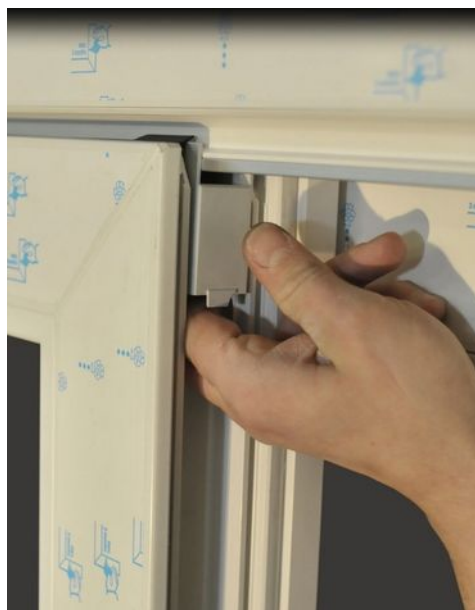
Obr. 62 – Vyjmutí pojistky
