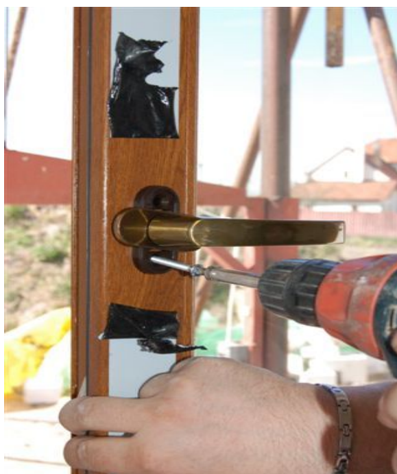
Obr. 47 – Osazení krytek na okno
