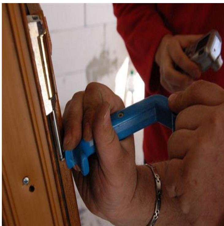
Obr. 21 – Vytažení závlačky z horního závěsu
