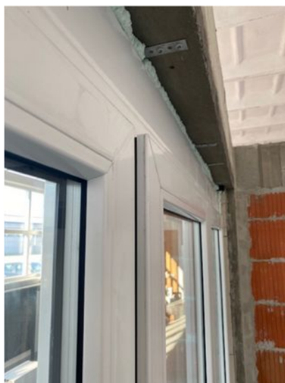
Obr. 86 – Minimální odsunutí mikroventilace křídla
