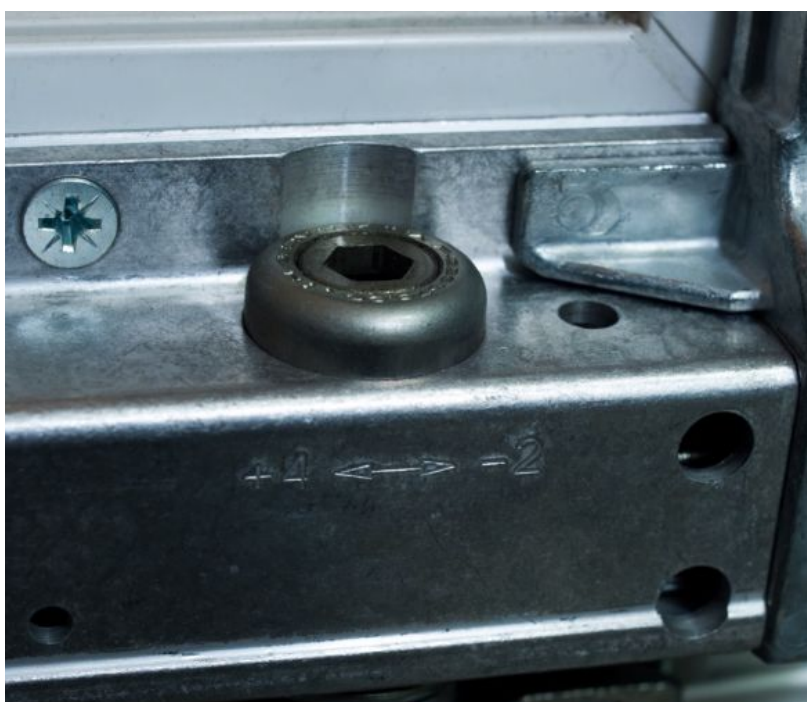
Obr. 59 – Servisní šroub na vozíku spodního pojezdu
