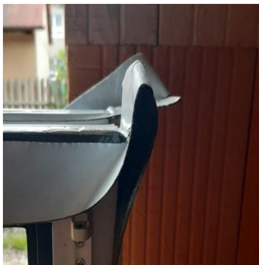
Obr. 24 – Nařazení těsnicí fólie v rohu
