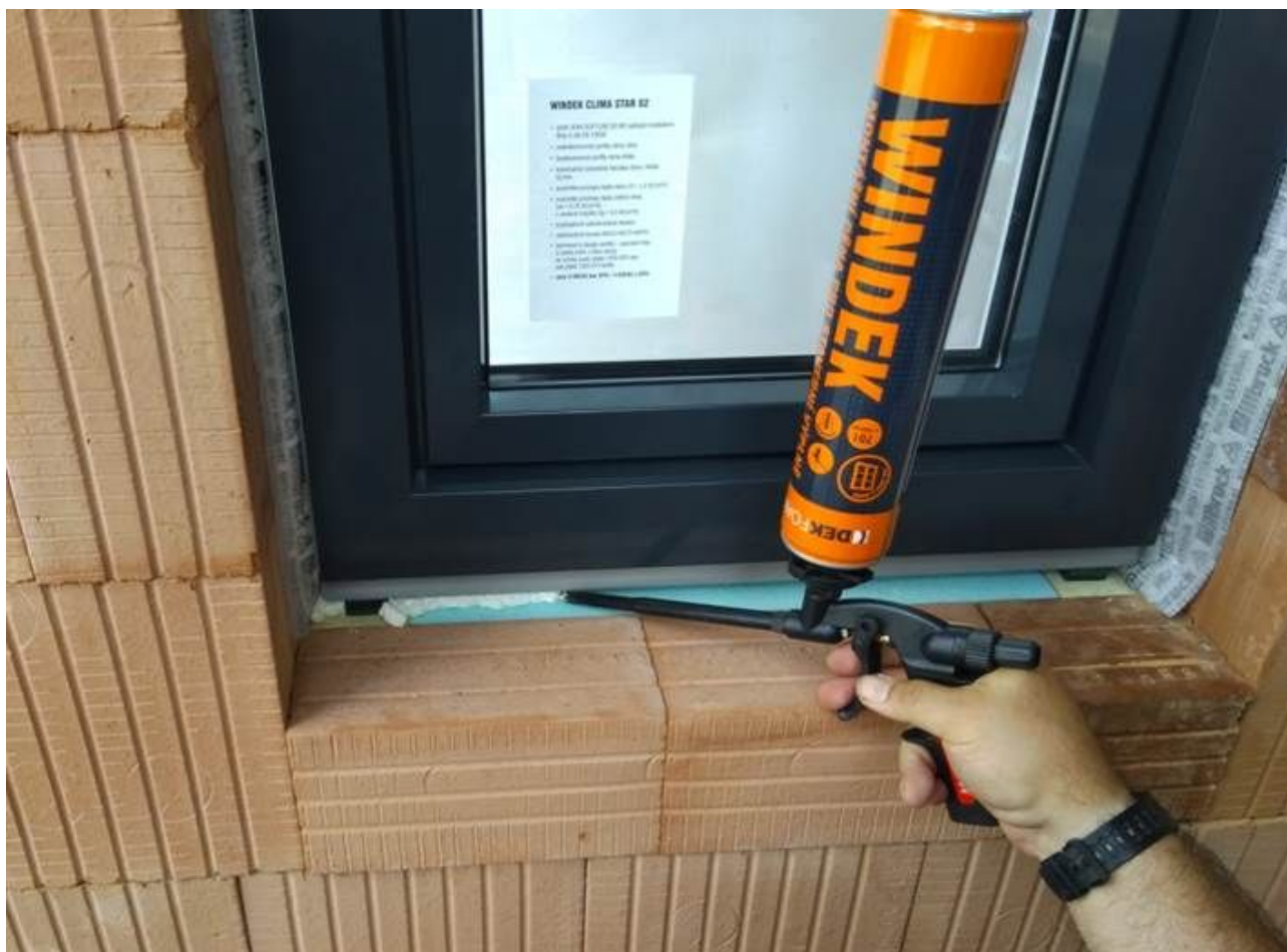
Obr. 43 – Vyplnění přípojovací spáry pěnou DEKFOAM WINDEK
