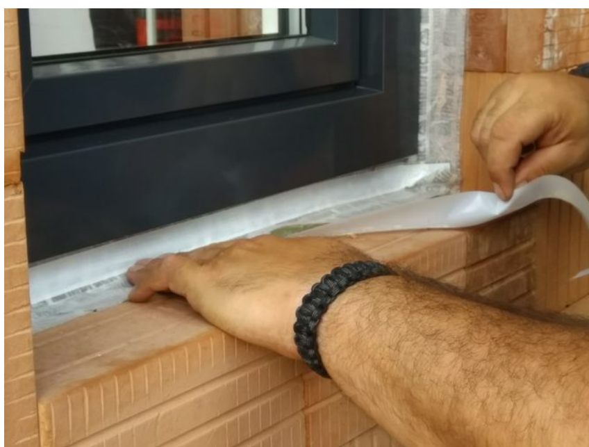
Obr. 46 – Nalepování těsnicí fólie v parapetní části
