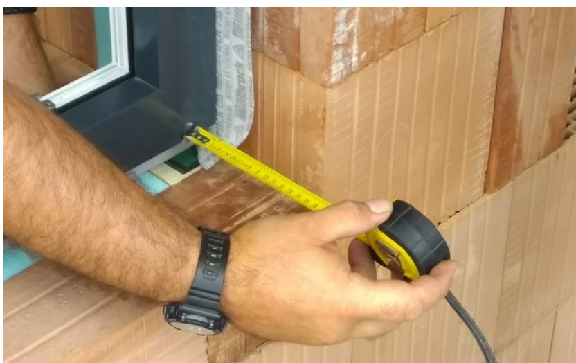
Obr. 28 – Kontrola vzdálenosti rámu od líce fasády
