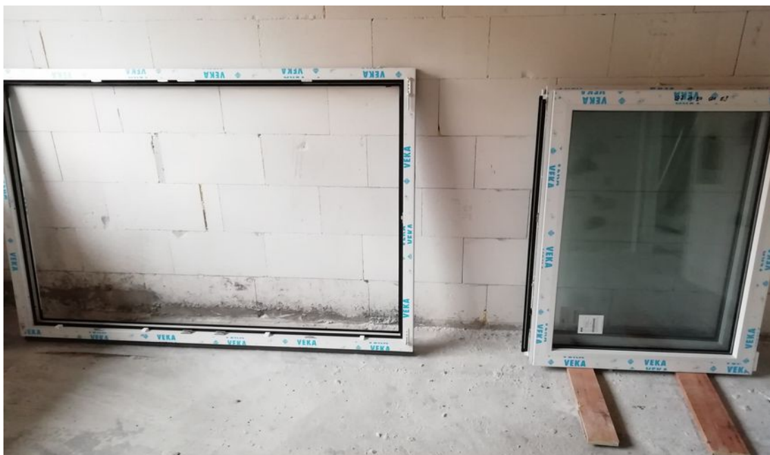
Obr. 19 – Správné uložení na stavbě – rám je uložen na podkladní profil a křídlo na hladké a čisté podložce
