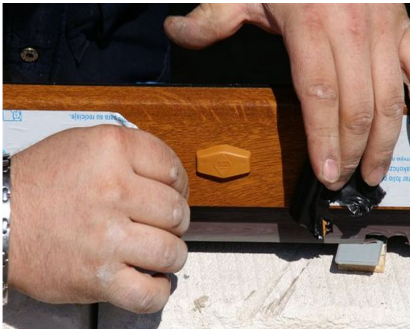
Obr. 47 – Osazení krytek na okno
