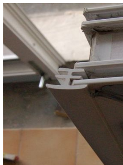
Obr. 14 – Detail osazeného spojovacího profilu
